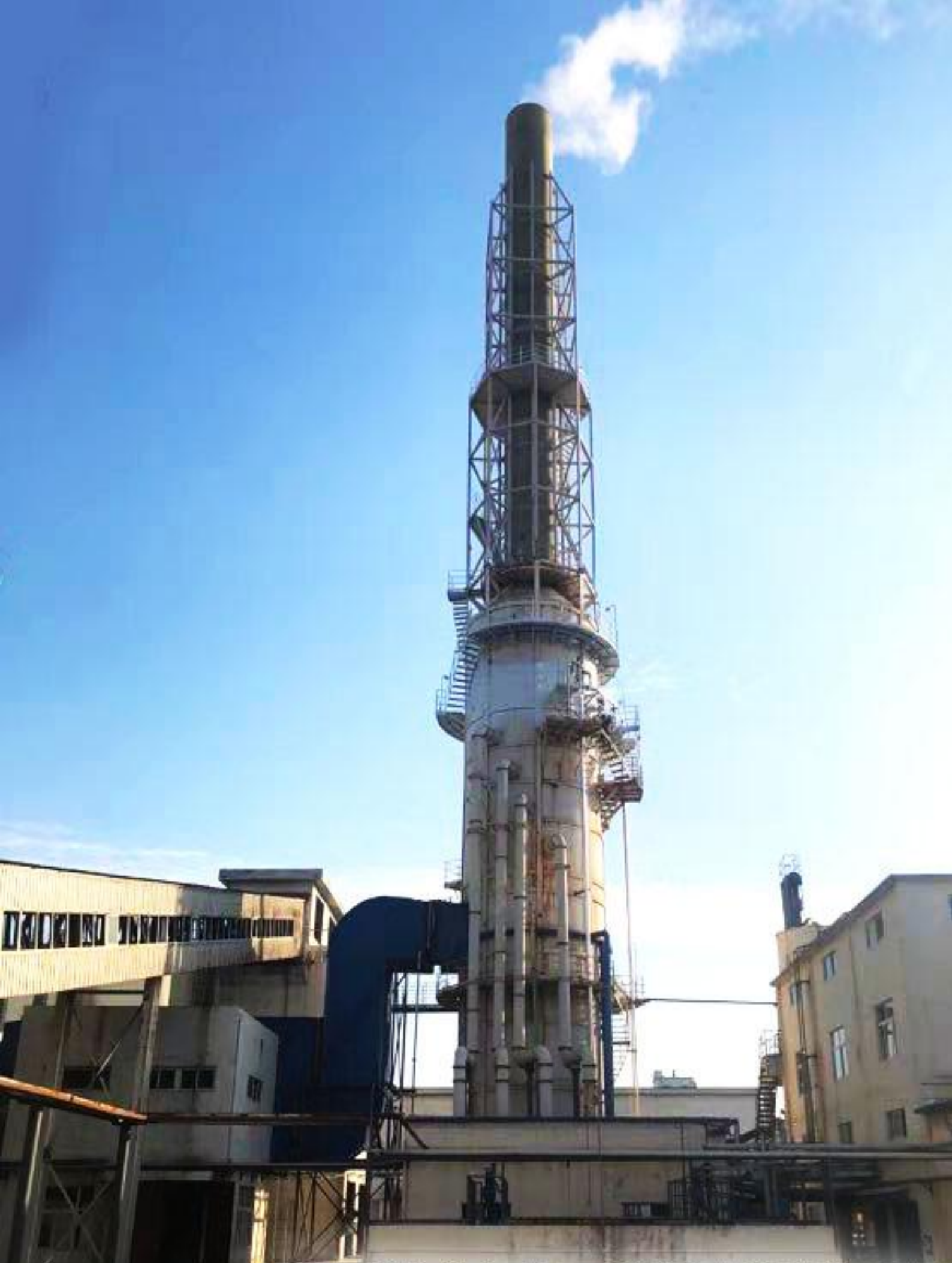
祁东煤泥矸石电厂脱硫系统改造工程
